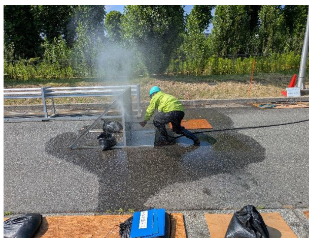
■塗装塗布面の剥離洗浄作業
