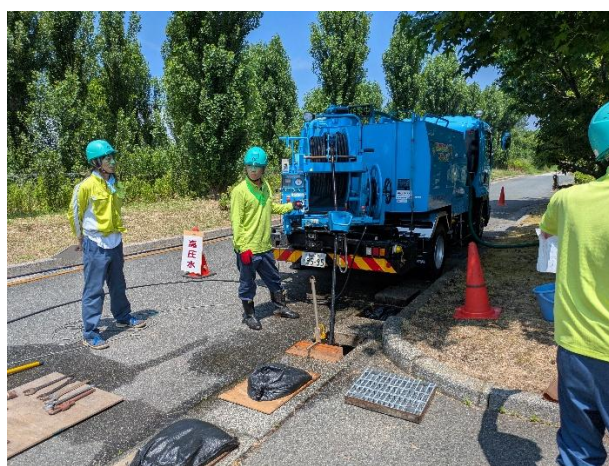
■下水道管の洗浄作業
